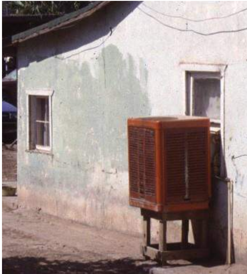
Enfriador evaporativo en Mexicali, Baja California. 1988
