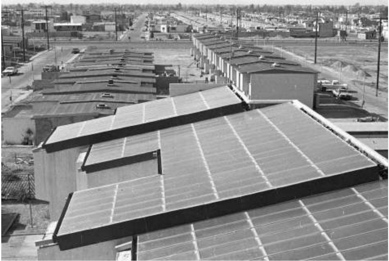
Calentadores solares montados en el techo la casa de máquinas de las instalaciones del sistema de refrigeración de un conjunto habitacional construido en Mexicali bajo el proyecto SONNTLAN llevado a cabo a principios de los años ochenta. Foto tomada en 1985.
