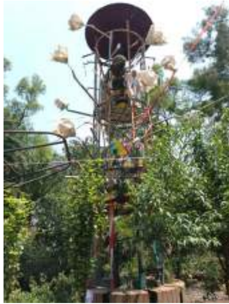
“Tinacoatl”, Sistema de captación de agua de lluvia para riego en Huerto Roma Verde, Resilab Ciudadano en la CDMX.
