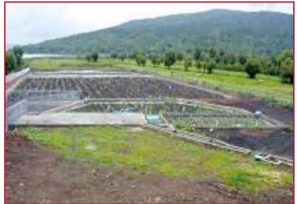
Ilustración 3.3 Humedal artificial de flujo subsuperficial subterráneo
